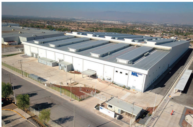
工事名：小糸製作所メキシコ第2工場新築工事 発注者：North American Lighting Mexico, S.A. de C.V.
