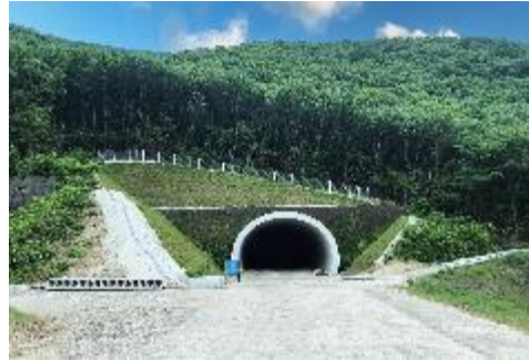
Goshikidai Tunnel (Kagawa Prefecture)
