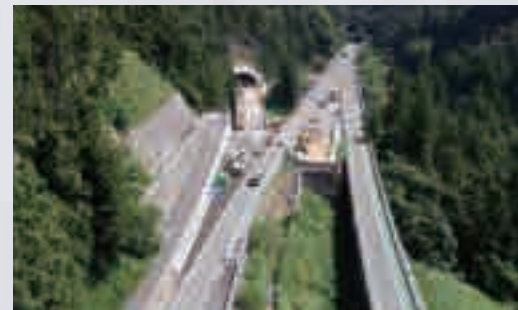
池島トンネル 上空から見た工事の様子
