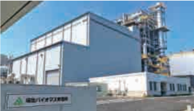
坂出バイオマス発電所
