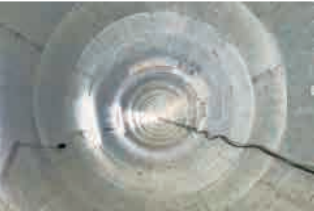
完成後トンネル内部
