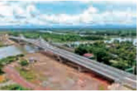
東西経済回廊整備計画、パッケージ1、 ジャイン・コーカレー橋建設事業（2023年 ミャンマー）
