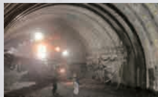
超高強度吹付けコンクリートの吹付け作業
