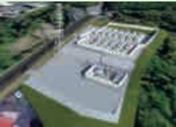
中津川蓄電所完成イメージ
