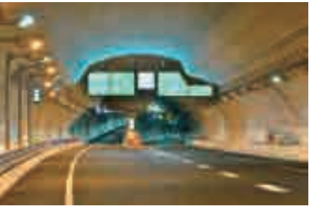
首都高速中央環状品川線大橋連結路（2014年 東京都）
