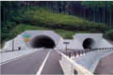
二重峠トンネル(阿蘇工区)（2020年 熊本県）
