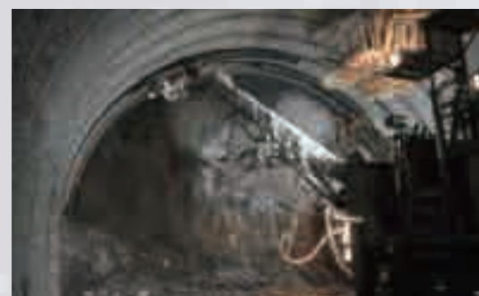
高規格鋼製支保工の設置
