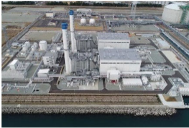
福島天然ガス発電所
