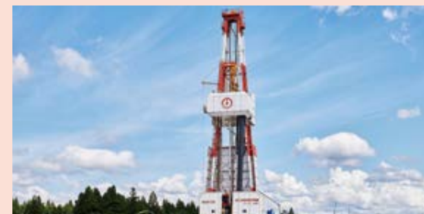
新潟県 片貝ガス田掘削作業場
