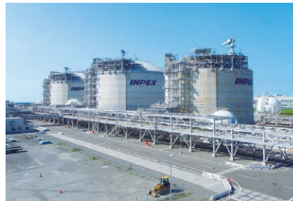
直江津LNG基地
