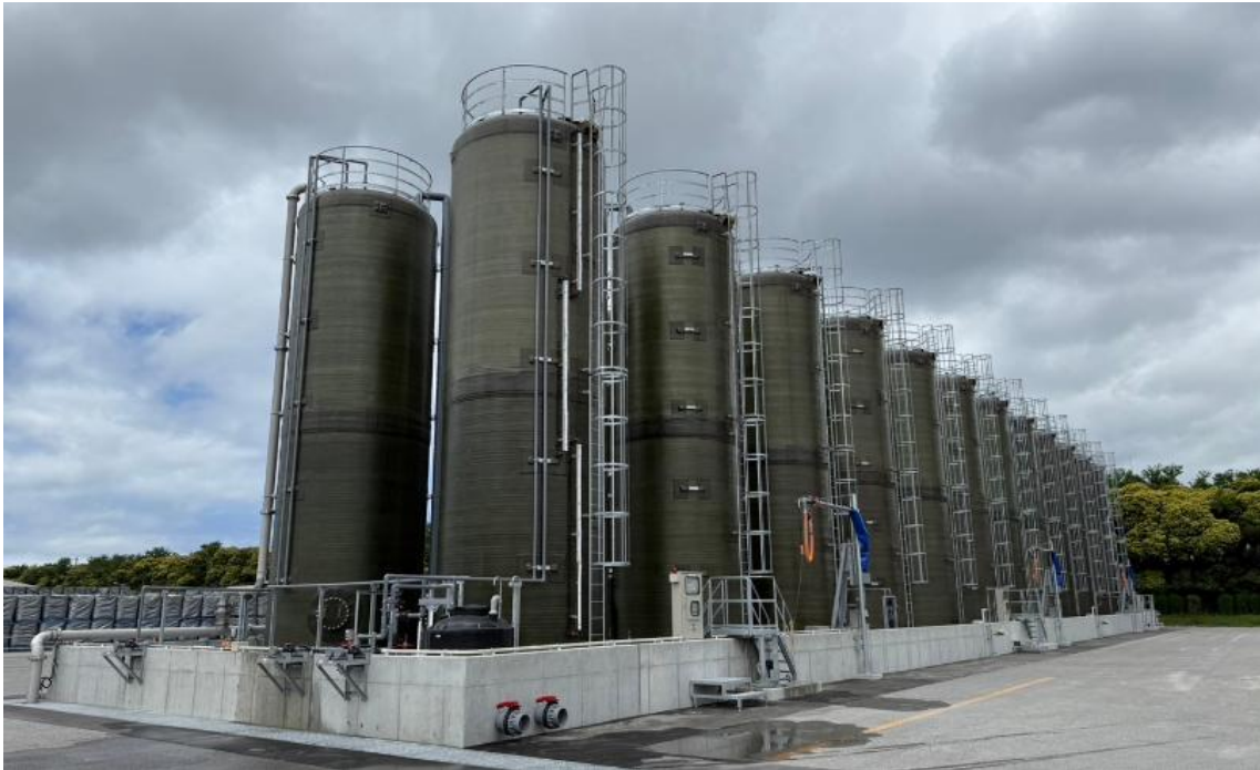
竣工した袖ヶ浦地区の貯蔵タンク基地
