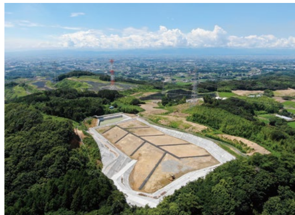
西武建設(株)の事業を通じた自然資本への対応事例 (土壌や地下水の汚染を防ぐベントナイト砕石施工)
