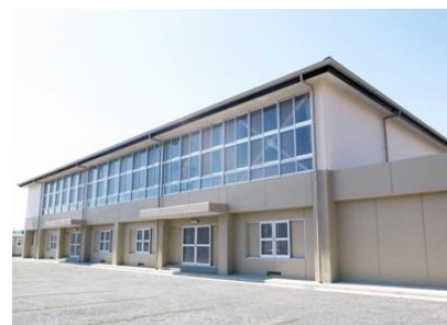
外壁押出成形セメント板工事
