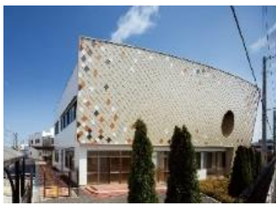
外壁押出成形セメント板工事
