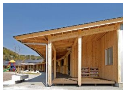
金属屋根工事
