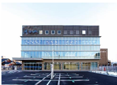
外壁押出成形セメント板工事
